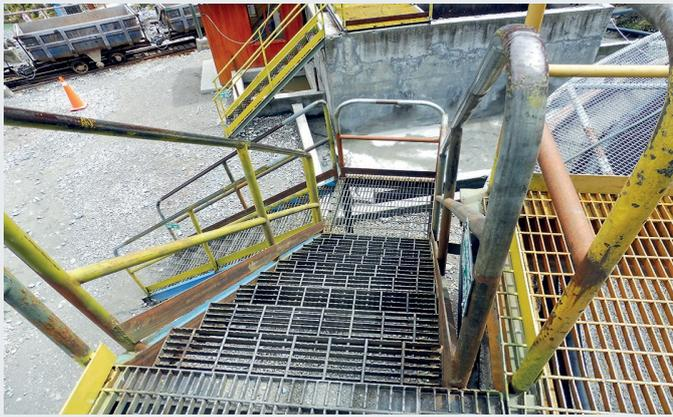
Gradas de acceso a espesadores de Cu, Pb y Zn, protegidas con barandas metálicas en ambos lados para evitar caída de trabajadores.
