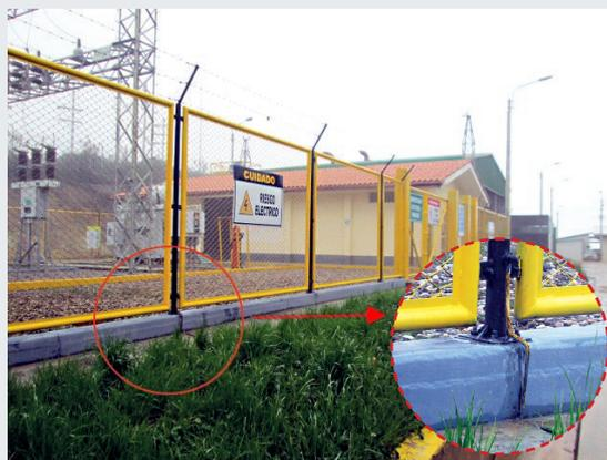
Cerco perimétrico de estación eléctrica con conexión de puesta a tierra.
