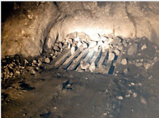
Vista del echadero sin muro de seguridad, incumpliendo la normativa que exige un muro con una altura de 2/3 de la llanta del equipo.
